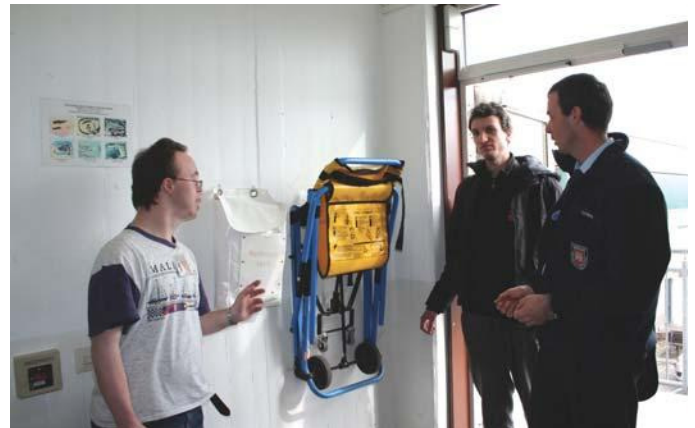
Bei der Brandschau werden auch Fluchtwege und Evakuierungshilfen kontrolliert
